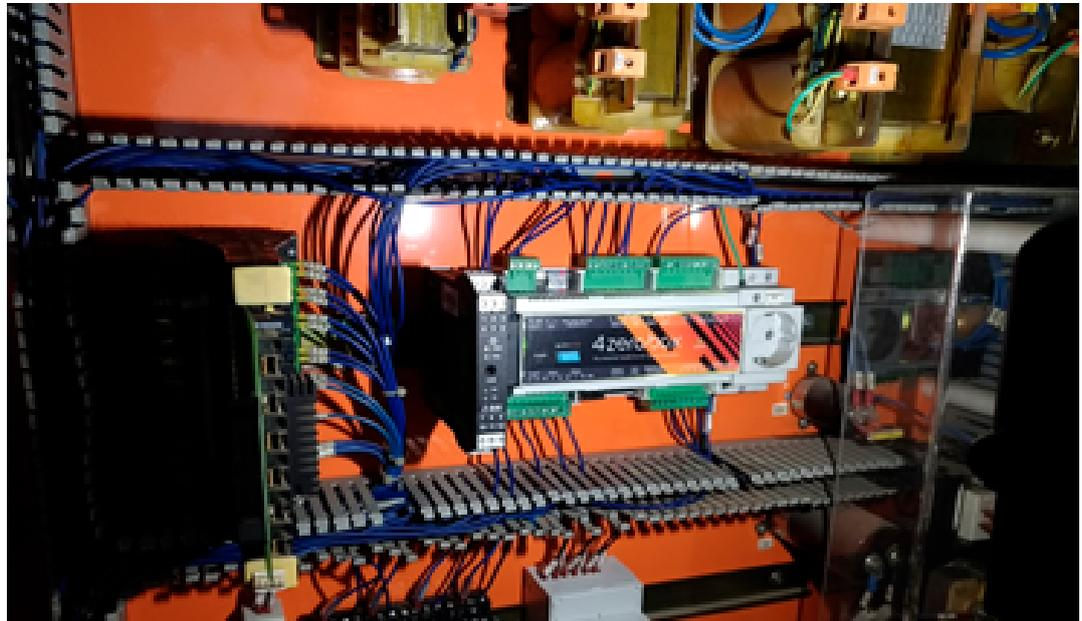
Immagine 4: il 4ZeroBox installato nel quadro elettrico della pressa
